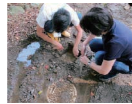
排水路の掃除で、長く絡んだ木の根を撤去しました。横井戸の流れが確認できました。
