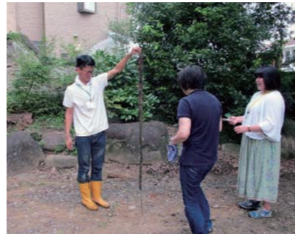
排水路の掃除で、長く絡んだ木の根を撤去しました。横井戸の流れが確認できました。
