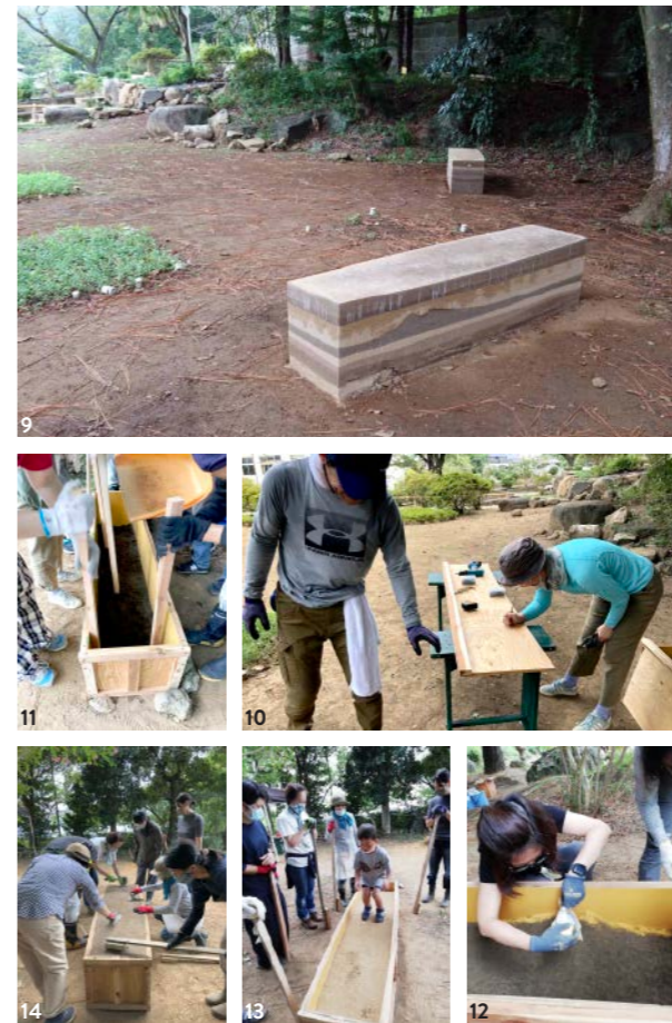
9 完成した版築ベンチ2台 10 型枠から制作しました 11 土を突き固めて重ねていきます 12 筑波山の山頂部分となる山富貴酸化黄（やまぶきさんかおう）を直接かけました 13 途中しっかり踏み固めて！ 14 最上面はコテでつるつるに仕上げます
